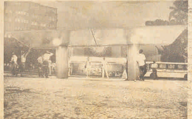
Atualmente, a praça é árida, sem canteiros floridos nem árvores frondosas.
