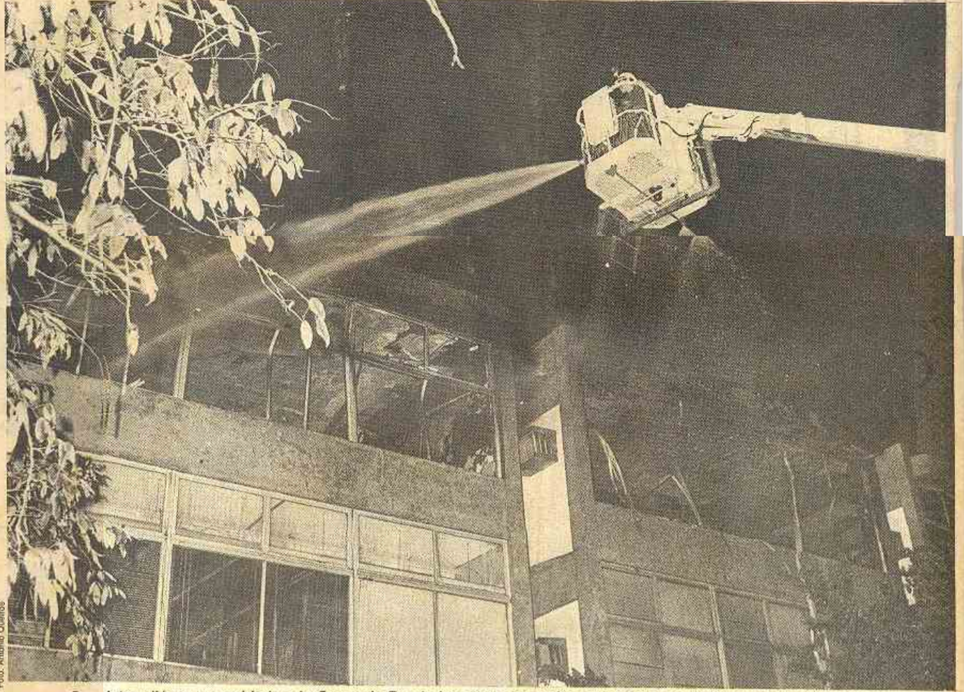
Com jatos d'água, os soldados do Corpo de Bombeiros tentavam evitar que o fogo se alastrasse para outros andares
