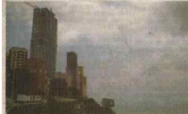
O edifício Morada dos Cardeais está em fase final de construção e oferece acesso direto à Baía de Todos os Santos.
