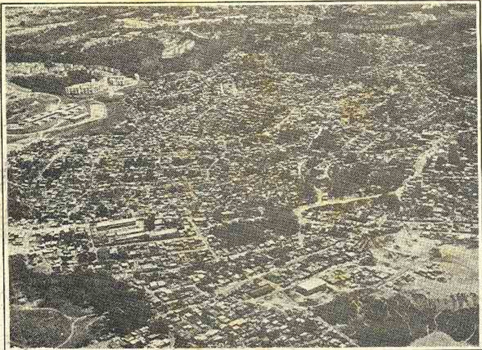
Vista aérea do bairro do Beiru e adjacências onde será executado o projeto pela Setrabes.
