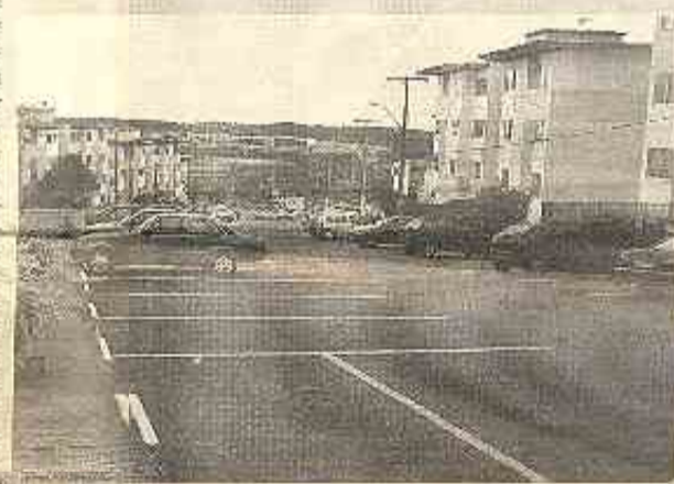
O Paralela Park, com prédios de três andares, é bem urbanizado
